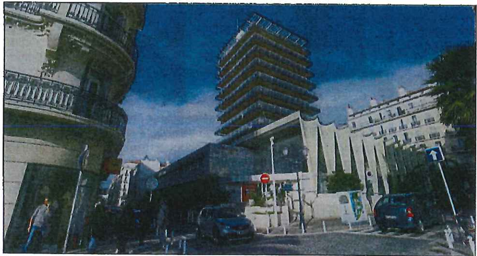
Il y a quelques mois, avant le démarrage du chantier.
