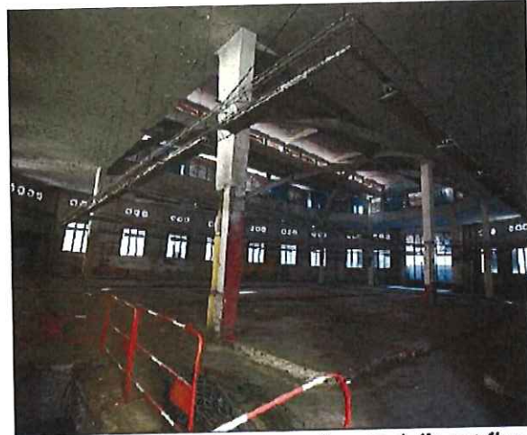
Si les travaux ont pris un peu de retard, ils ont finalement démarré à la toute fin novembre.
