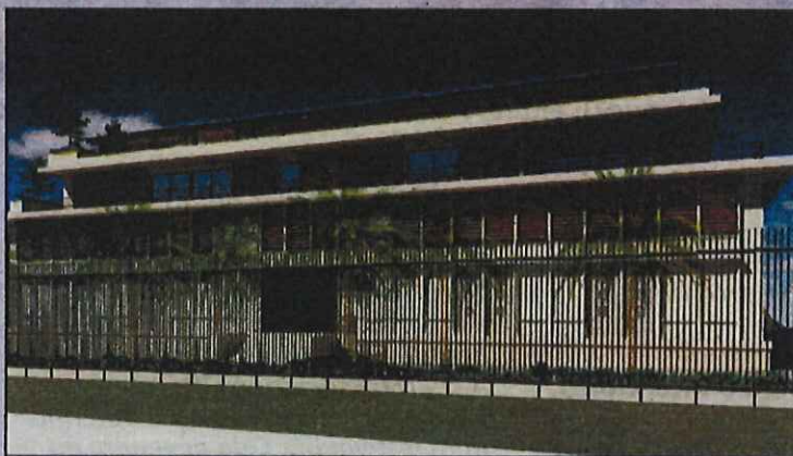
Un data center et des espaces dédiés aux startups de la région sont prévus ici. (Photo-repro DR)
