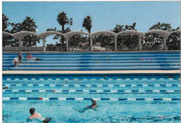
Le bassin extérieur de la piscine du Port-Marchand, qui représente à lui seul 45 % de la dépense globale des piscines, va être fermé les trois premiers mois de l'année pour faire des économies d'énergie. (Photo doc. F.M.)
